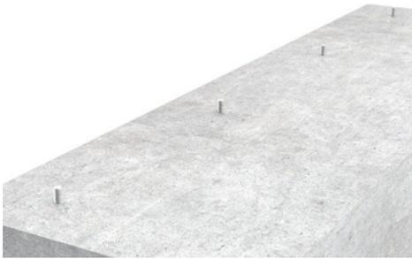
1. Bohren, absaugen, Kleber und Verbundanker einsetzen.
