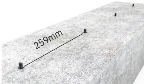
1. Bohren, absaugen, Kleber und Verbundanker einsetzen.
