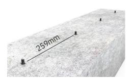
1. Bohren, absaugen, Kleber und Verbundanker einsetzen.
