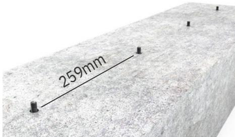
1. Bohren, absaugen, Kleber und Verbundanker einsetzen.
